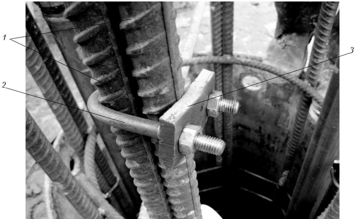
Рис. 7. З'єднуючий арматурні стрижні металевий хомут:
